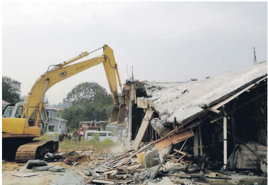
Struktur rumah yang dirobohkan di Sungai Chinchin, Gombak semalam.
